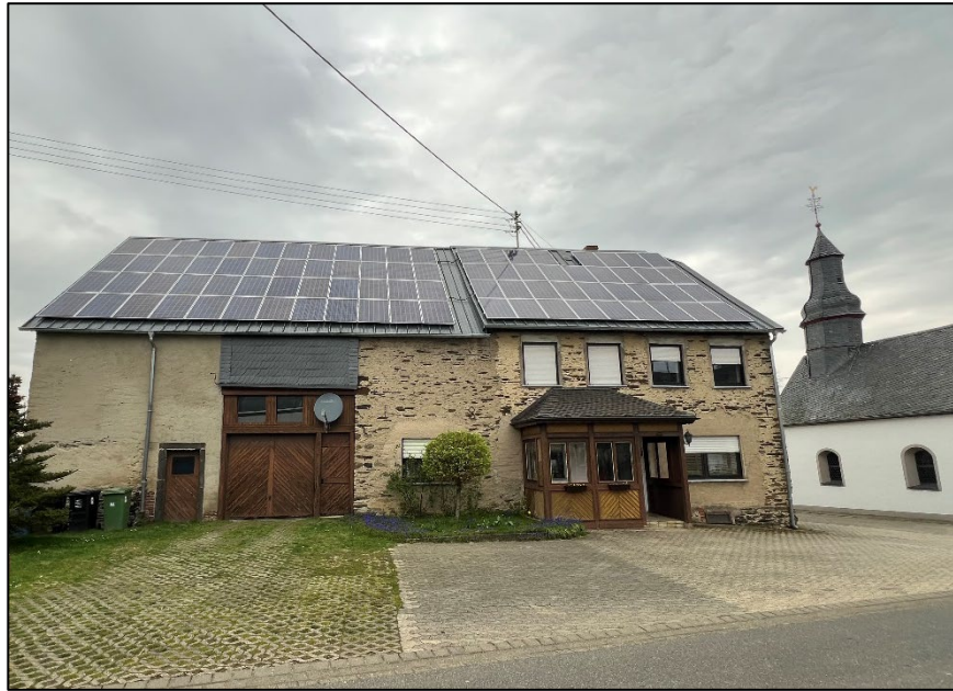
Abbildung 2-11: Gebäude mit PV-Anlage im Quartier
